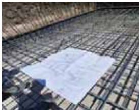
Temel donatılarının kontrolü
